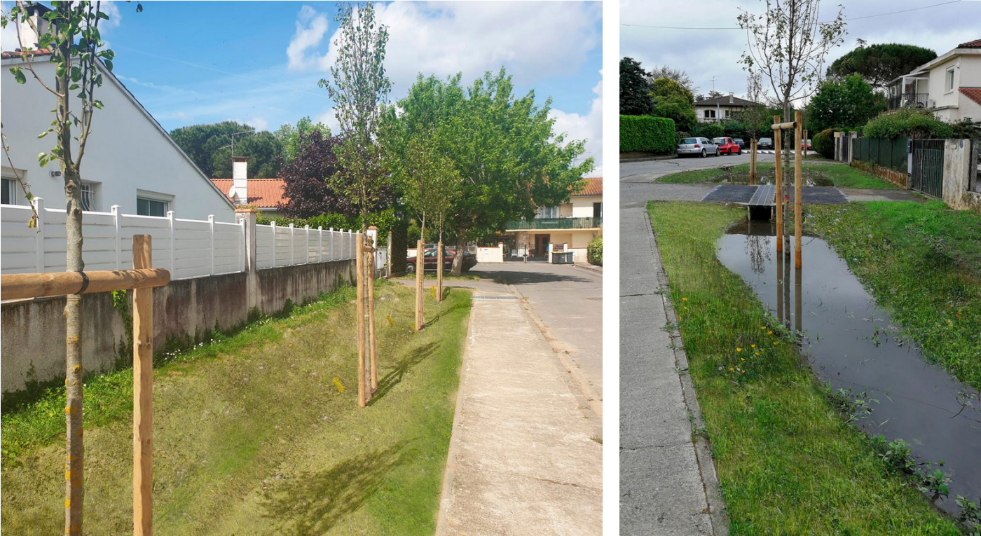
Intégration d'une noue le long des trottoirs, Quartier Renoir _ Portet-sur-Garonne (31)_ATM_2017-2019
