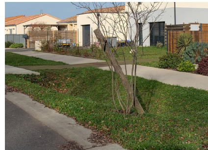
Noue végétalisée avec infiltration gravitaire (source : Cittanova)
