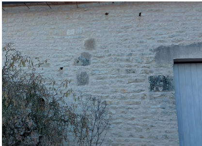
Trous dans les murs en moellons (source : Cittanova)
